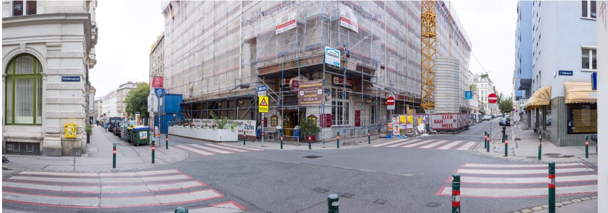
Abbildung 22: Kreuzungsbereich Zieglergasse – Seidengasse und Baustelle
